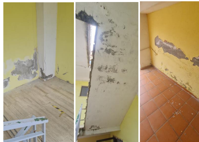
Manutenzione Ordinaria e straordinaria del plesso: Esempio la zona della Scala che porta al locale Mensa
